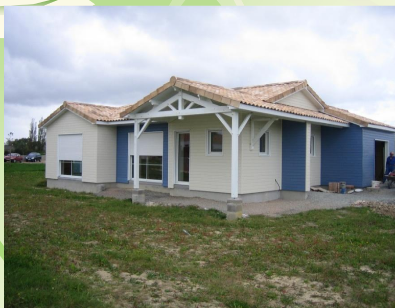
Maison ossature bois. Falleron (85)
