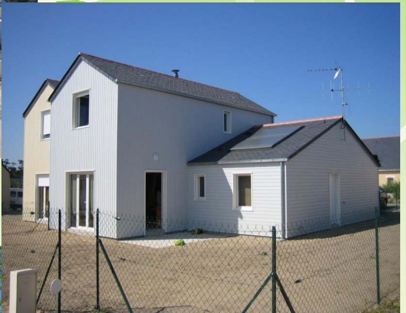
Étage complet en ossature bois. Saumur SDIS (49)
