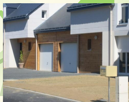
Construction mixte brique et garage en ossature bois. Montreuil Juigné.(49)
