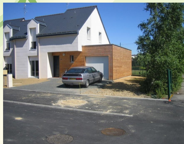
Construction mixte brique et garage en ossature bois. Montreuil Juigné.(49)
